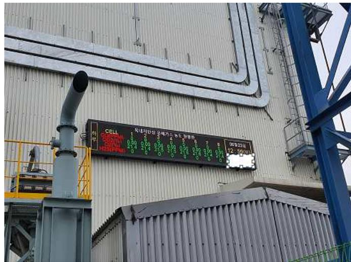
[그림 A4-14] 옥내저탄장에 출입구에 설치된 가스농도 알림판
