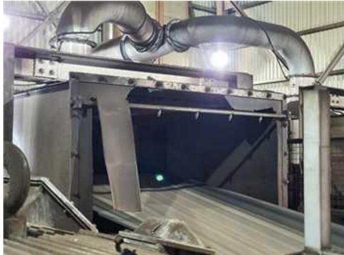
[그림 A3-11] 국소배기장치 후드의 사이드 커튼이 파손된 모습
