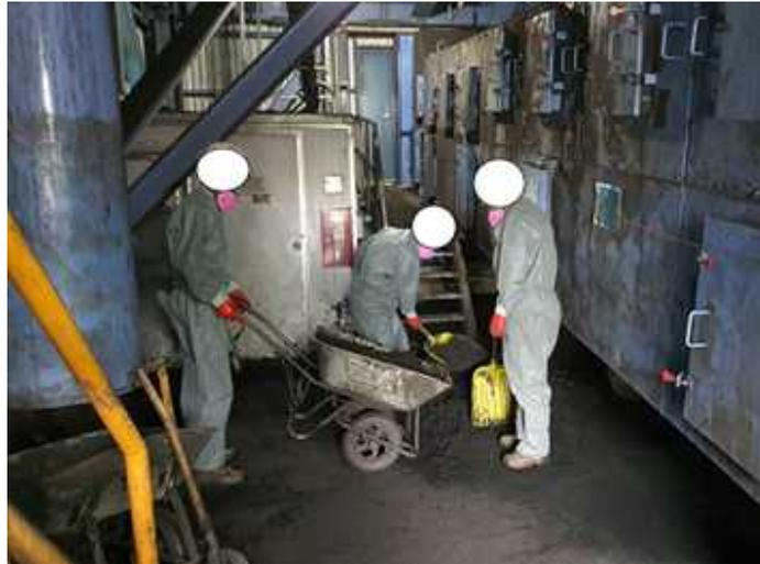
[그림 A3-5] 낙탄을 삽질하여 대차에 담는 모습
