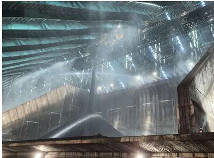
[그림 A4-12] 옥내저탄장에 설치된 분무장치와 살수장치
