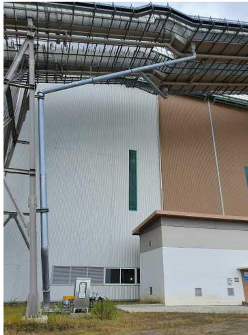
[그림 A4-4] 컨베이어라인 경사로 하부에 설치된 배수관
