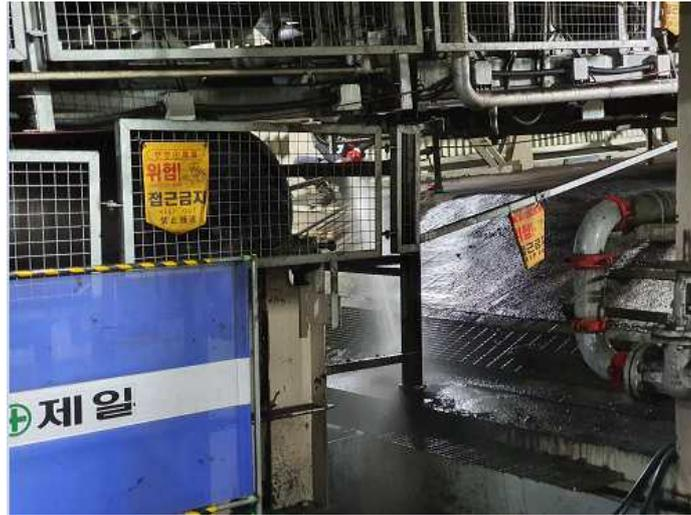
[그림 A4-3] 컨베이어라인 경사로 하부에 설치된 배수구
