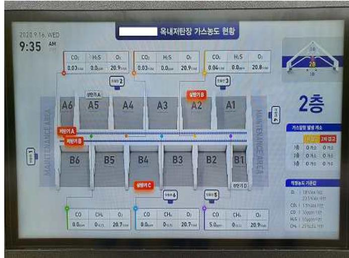
[그림 A4-13] 옥내저탄장에 출입구에 설치된 가스농도 알림판
