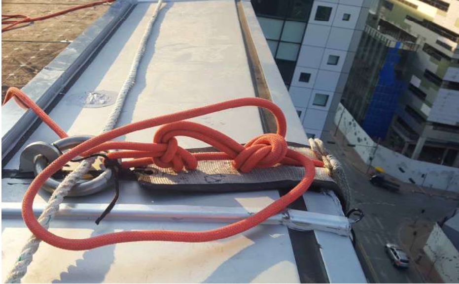
[그림 Ⅲ-9] 청소용 고리에 자일 로프가 설치된 모습
