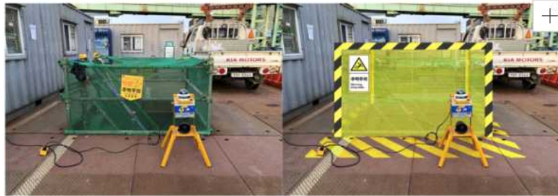
▲ 사고가 빈번한 출입구 및 수직통신의 주의를 강조하는 작업장 출입구 및 계단(좌:개선 전/ 우:개선 후) ▲ 사고가 빈번한 출입구 및 수직통신의 주의를 강조하는 작업장 출입구 및 계단(좌:개선 전/ 우:개선 후) (자료제공=서울시)
