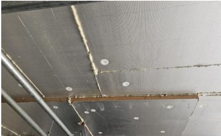
[그림 II-2] 경질 우레탄 폼 보온판 시공 모습
