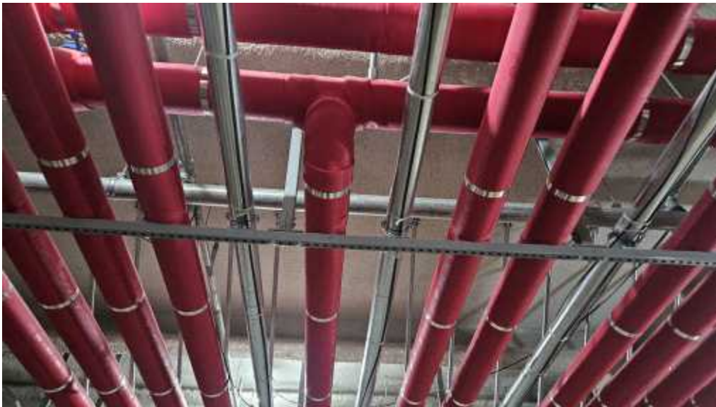
[그림 II-4] 배관 보온재 시공 모습
