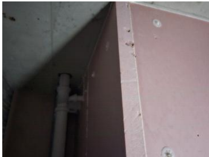
[그림 II-1] 압출법 보온판 시공 모습
