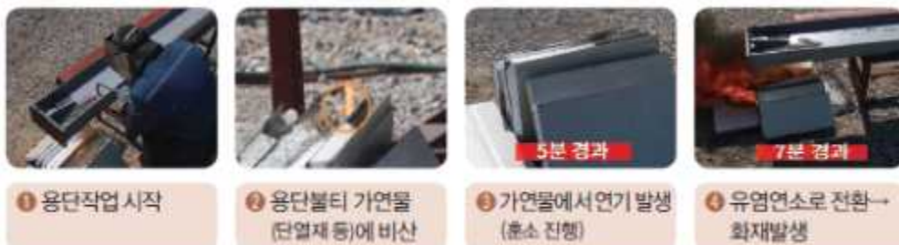
[그림 V-4] 용단 작업 시 화재 발생 과정
