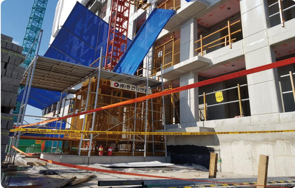
[사진 1] 재해자가 설치 중이던 낙하물 방지망, 재해자 추락 지점
