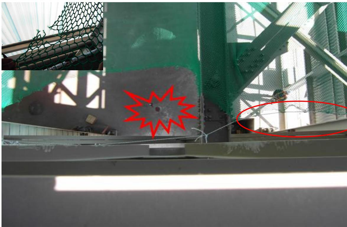
재해발생 위치(상부모습)와 안전방망 파단 모습 및 테두리로프 설치 모습
