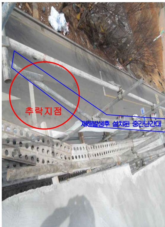
재해발생구간 작업발판 및 안전난간대 설치상태
