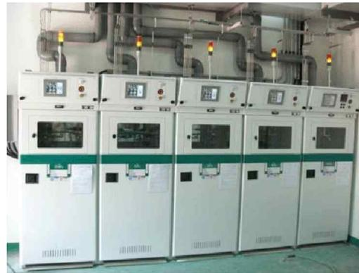
[그림 2-22] 가스 공급장치(Gas Cabinet System)
