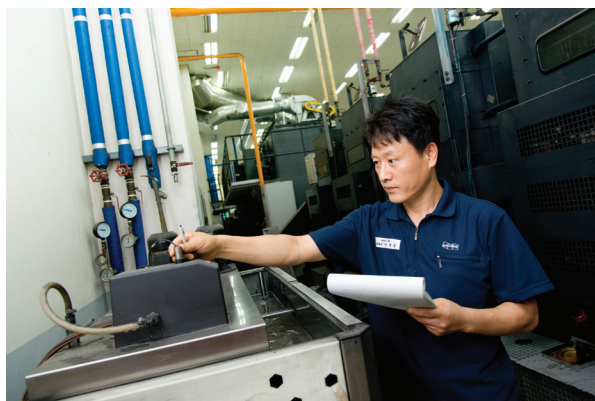
윤전기 내부에 냉각수를 공급해 최상의 인쇄품질을 보장하는 한편, 인쇄설비의 고장을 막고 화재가 발생하지 않도록 관리를 철저히 한다.
