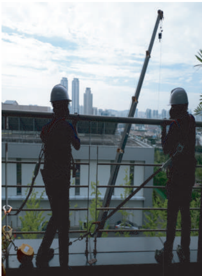
중량물 반출을 위해 발코니 안전난간 탈부착 중 떨어짐 위험
