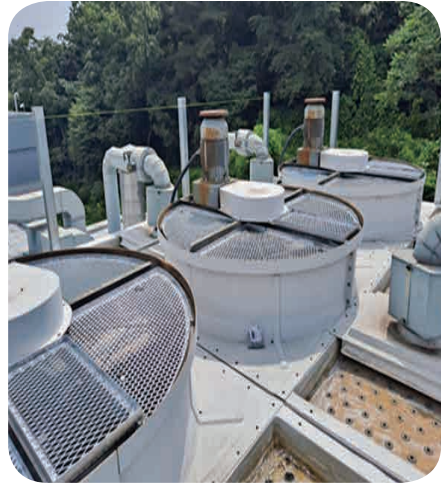
작업 중 웬이 회전하지 않도록 전원을 차단 후 메쉬망 설치
