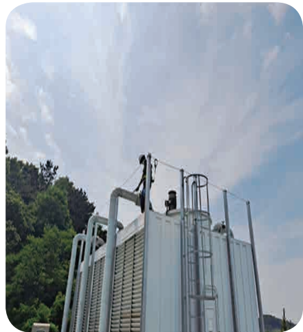
안전난간 기둥 및 안전대부착설비 설치
