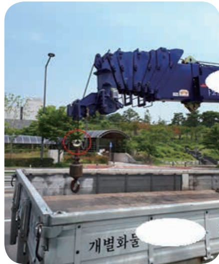
권과방지장치 설치 후 양중
