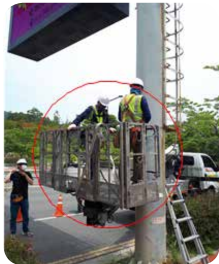
고소작업대 교체(안전난간 설치)
