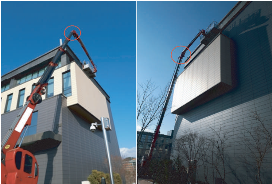
외벽 돌출부위 일반 고소작업대(차량 탑재형)로 작업 불가 ☞ 돌출부위에서 작업 가능한 굴절형 고소작업대(차량 탑재형) 사용
