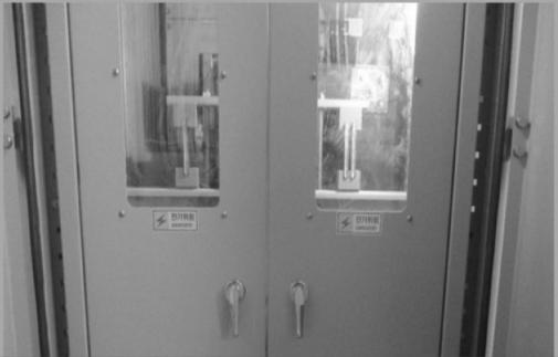
특고압반 후면 열화상 점검 시 패널 속판 door 를 열어서 측정해야 하는데 점검자 부주의로 특 고압부 인체 접촉 및 접근에 의한 안전 위험
