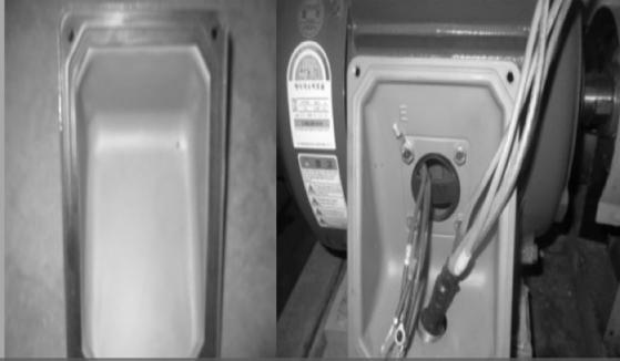
열화로 인한 케이블 손상과 Motor의 반복적인 진동으로 케이블이 단자함 내부에 접촉 시 전기 사고 발생 위험
