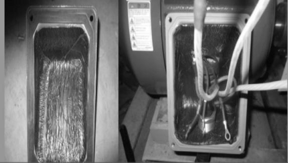
Motor 단자함 및 커버 내부에 부틸러버를 부착하여 전기 사고를 방지함. 절차서에 추가하여 Motor 결선 작업 시 단자함 내부 절연 작업 실시
