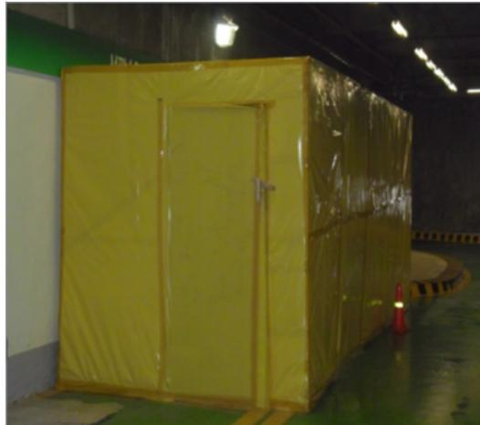
[그림 10-8] 석면폐기물 별도 보관장소 설치 예시
