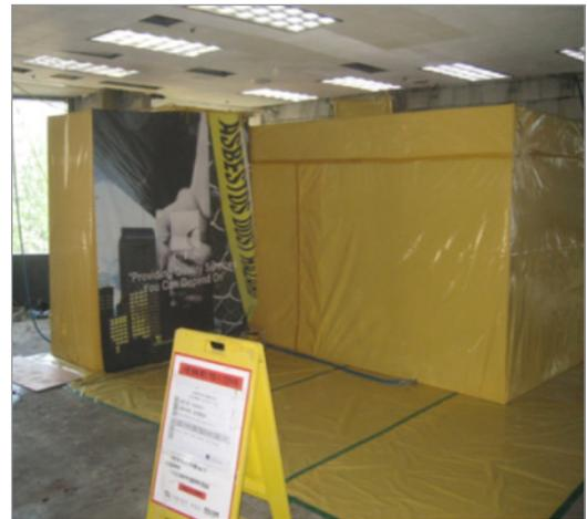
[그림 10-7] 위생설비 측면에 설치한 석면폐기물 반출구 예시
