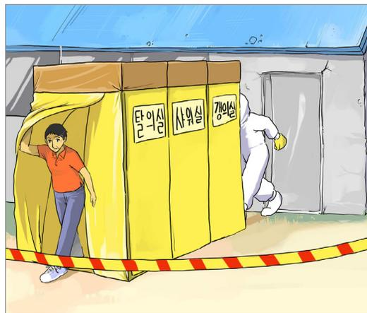
[그림 5-2] 지붕슬레이트 해체·제거작업 인근에 설치된 위생설비
