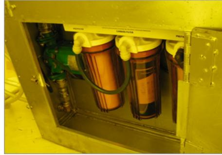
[그림 5-5] 냉온수기 및 배수여과장치 설치 예
